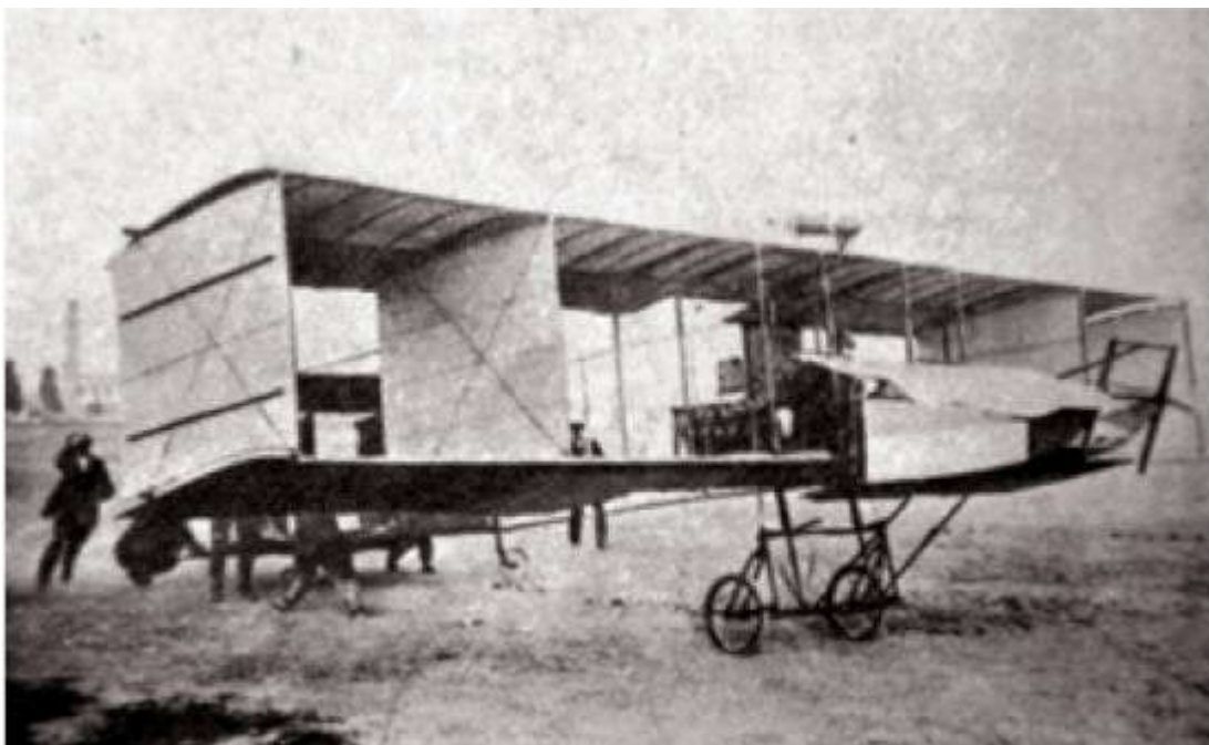
Disposición inicial del tren de aterrizaje, dos ruedas principales, dos traseras.
