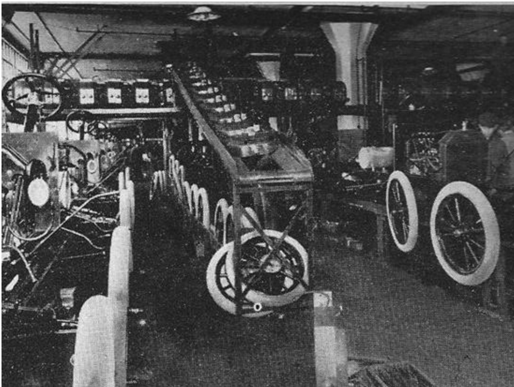
Cadena de montaje de la Ford: ruedas y radiadores se colocan al mismo tiempo (1914).
